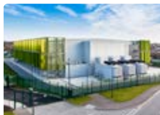
KAO – data centre fitout
